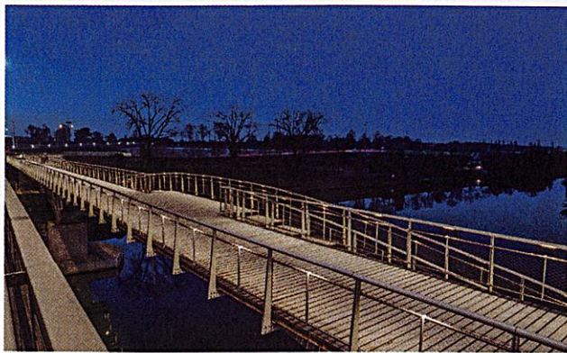
Deux travées métalliques de 60 m de long composent la passerelle.
